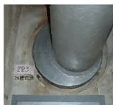
貫通部の止水処置(例)
